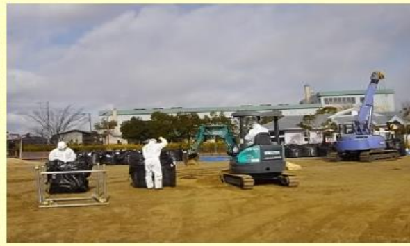
除去土壌詰込状況
