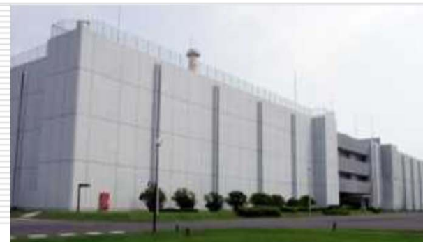
プルトニウム燃料第3開発室 Plutonium Fuel Production Facility PFPF (1988 - )
