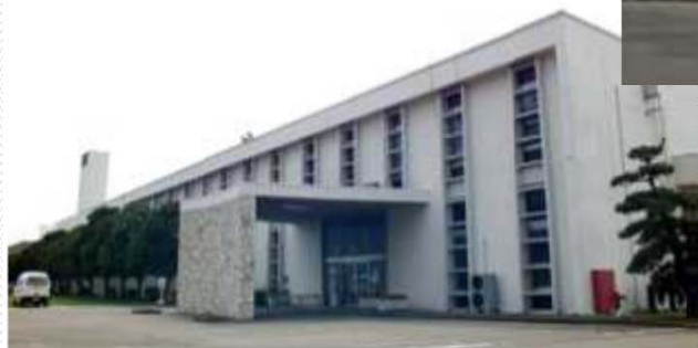
プルトニウム燃料第1開発室 Plutonium Fuel Development Facility PFDF (1965 - )
