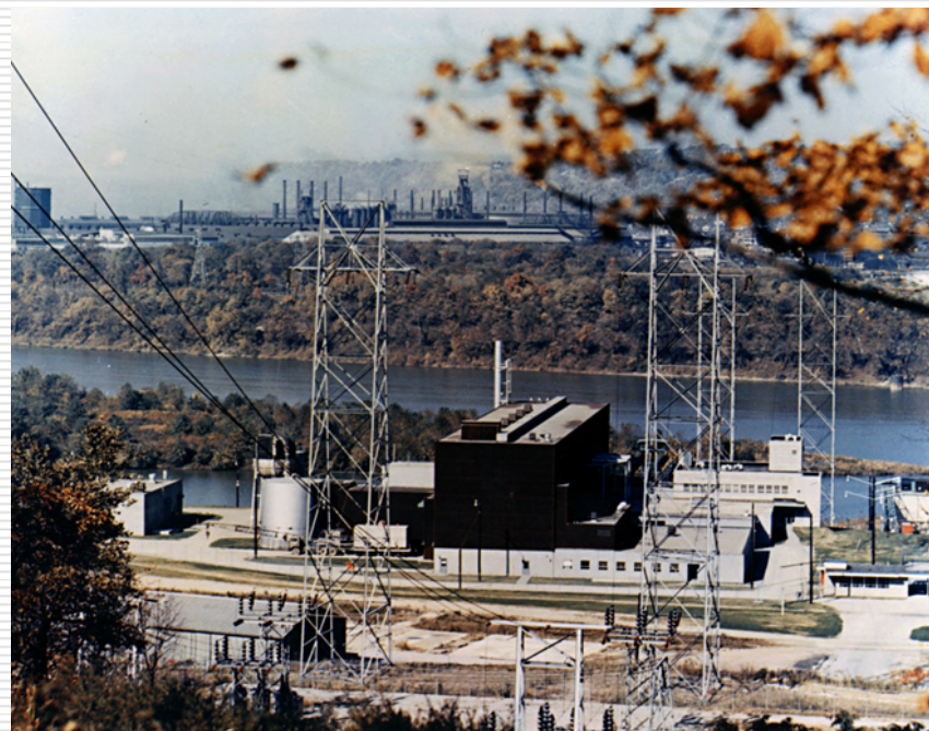
SHIPPING PORT 原子力発電所 ピッツバーグ
